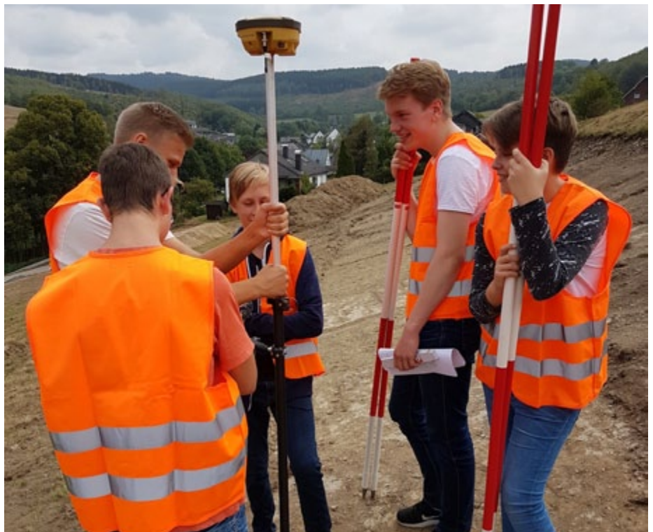
Bei der Vermessung der Tiefbaustelle kommt neueste GPS-Technik zum Einsatz.
