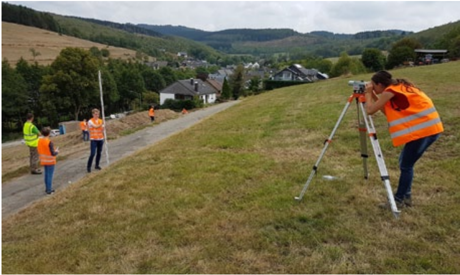
Eigenständig vermessen die Schüler die Tiefbaustelle.
