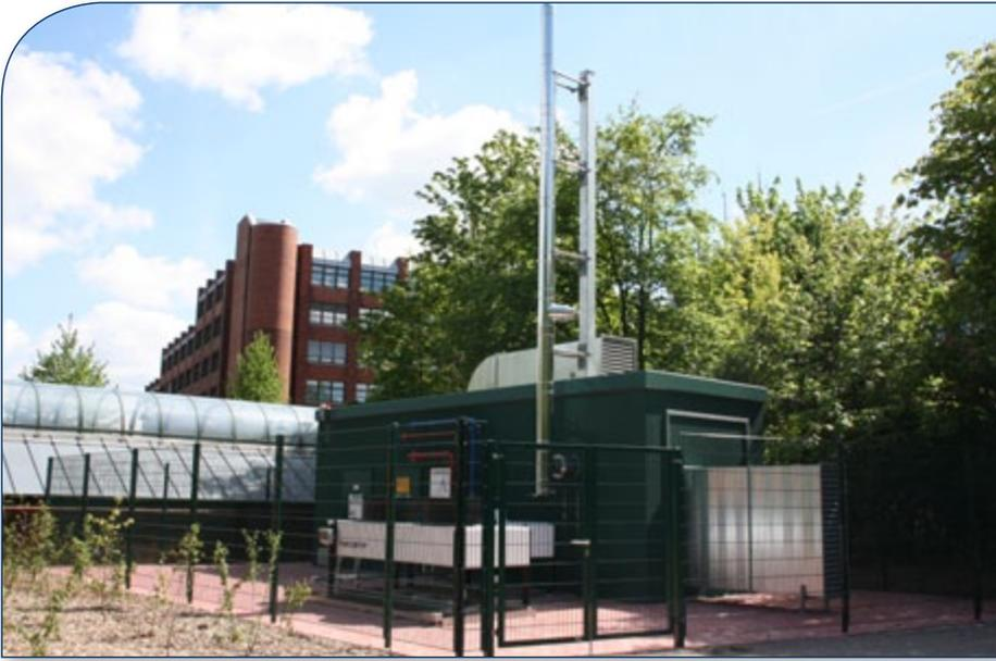
**Das neue Blockheizkraftwerk wird durch Deponiegas gespeist und versorgt das Kreishaus (im Hintergrund) mit Strom und Wärme.**
