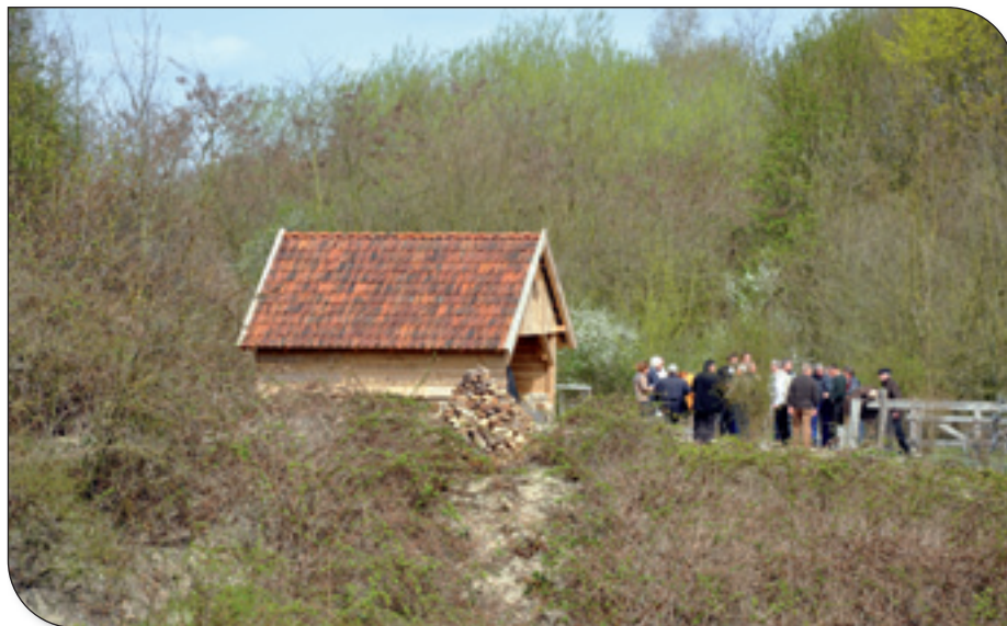
Ein historischer Schafstall ist in einem Naturschutzgebiet neu gebaut worden.
