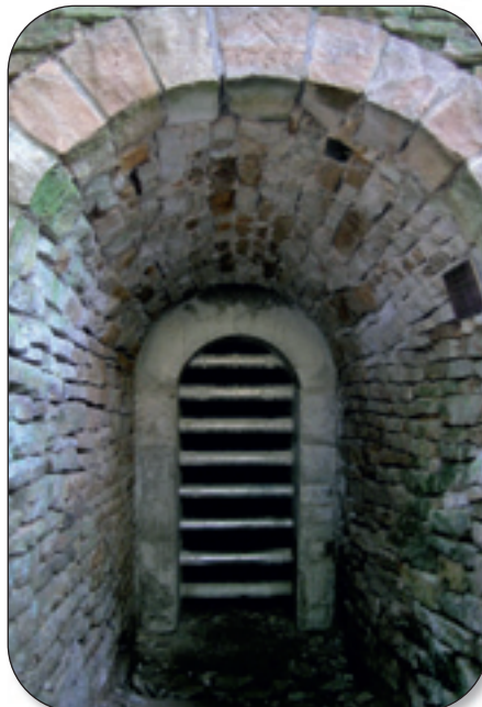
Dieses Beispiel zeigt einen Schieberohr-Verschluss, der effektiv ungebetenen Besuch aus dem Stollen fernhält. Die Fledermäuse aber kommen rein.
