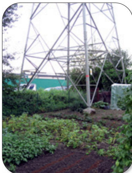
Hier steht der Problemfall mitten im Nutzgarten. Es gibt Handlungsbedarf...
