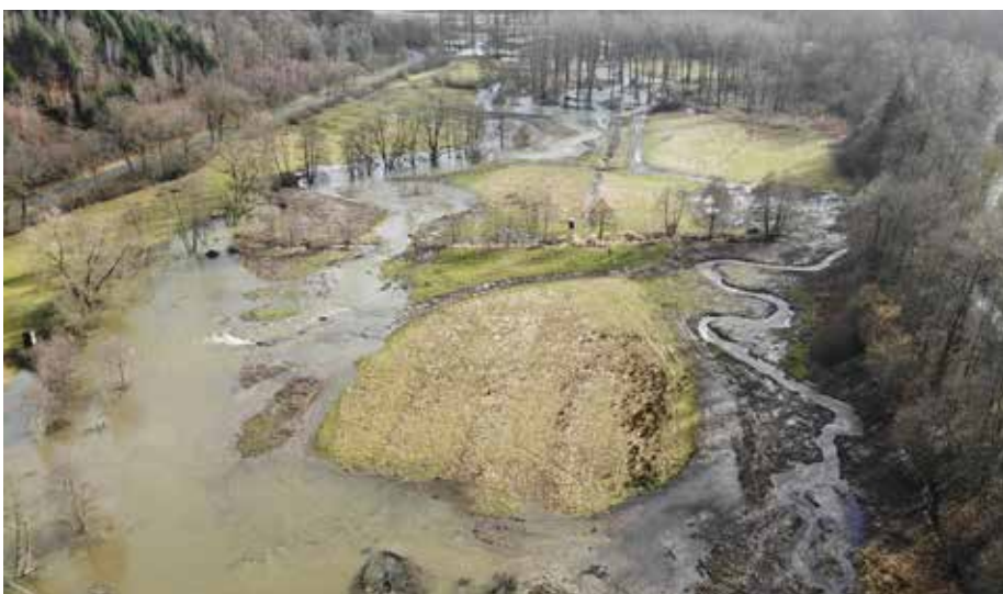
Bei Hochwasser kommt es jetzt wieder zu breiten Überflutungen, was ökologisch bereichernd ist und für die unterhalb gelegenen Ortschaften einen Beitrag zum Hochwasserschutz bedeutet. Quelle: WOL
