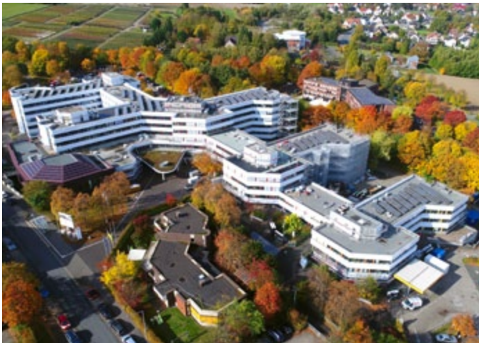
Das sanierte Kreishaus in Detmold.
