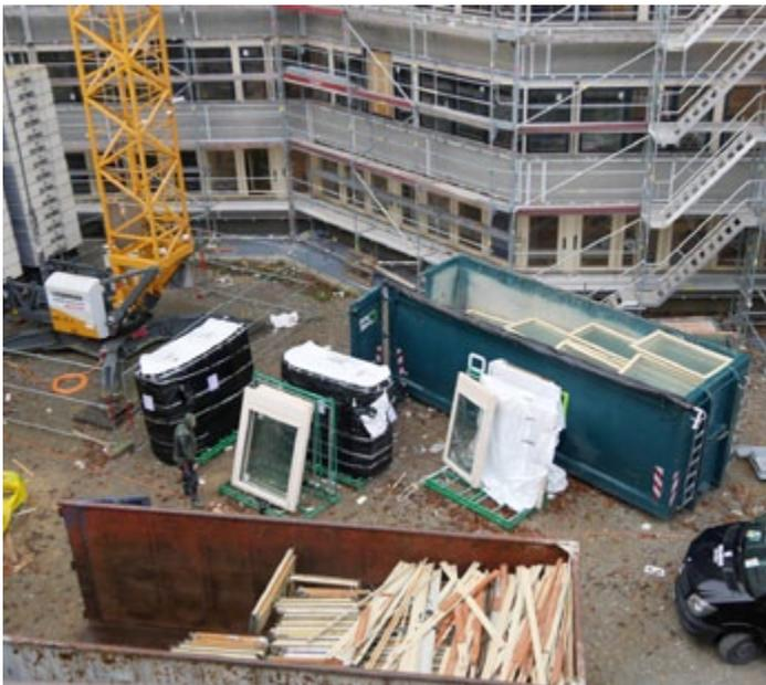
Alt vs. Neu: 2.400 Fenster aus dem alten Bestand müssen weichen. Das Kreishaus durchläuft gerade das Upgrade zur Dreifachverglasung.
