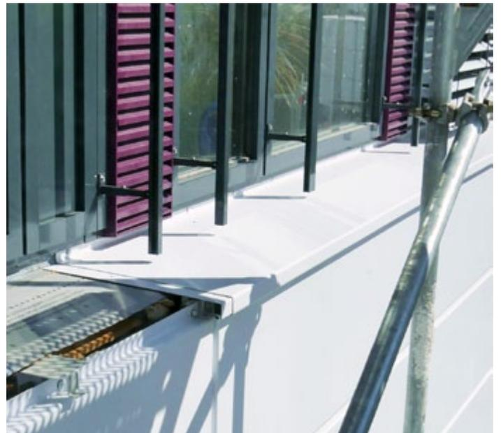
Extra dünn: Mit einem speziellen Verfahren konnten die Planer bei der Fassadenverkleidung noch einmal 30 Prozent Aluminium einsparen.
