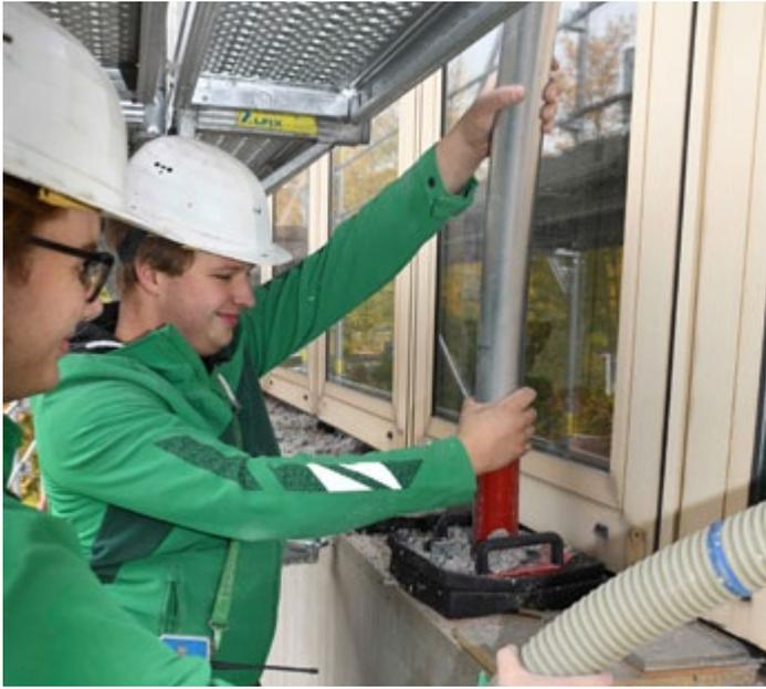
Die neue Fassade des Kreishauses wird mit Zellulose gedämmt. Die Fasern werden dafür in hohle, vorgefertigte Fassadenelemente eingblasen.
