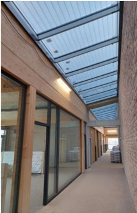
**Fassade aus wiederverwendeten Ziegeln aus der Region, Glasdach mit Einstrahlungswinkel abhängigem Sonnenschutz und elementierte Glas-Trennwände.**
