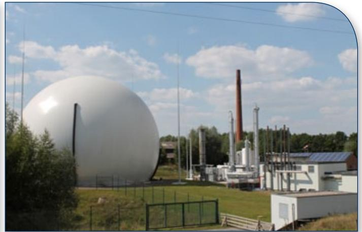
Abbildung 3: Biogasaufbereitungsanlage mit Biogasspeicher (WBC).
