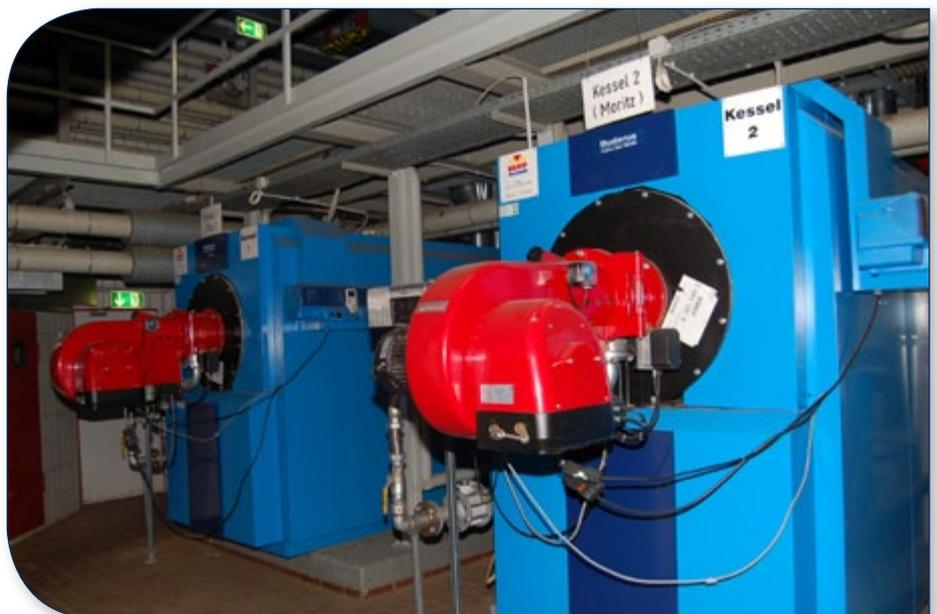
Max und Moritz: Die beiden neuen Gas-Brennwertkessel mit einer Gesamtleistung von 1.500 kW Heizleistung ersetzen die fast 40 Jahre alte Vorgängeranlage. Foto: Kreis Düren
