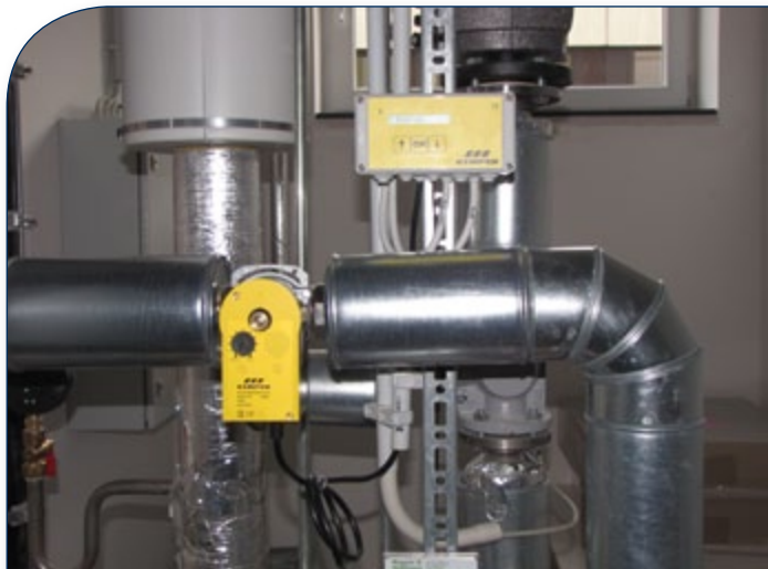
Installation einer automatischen Absperrereinrichtung in der Frischwasserleitung mit Steuerungseinheit.
